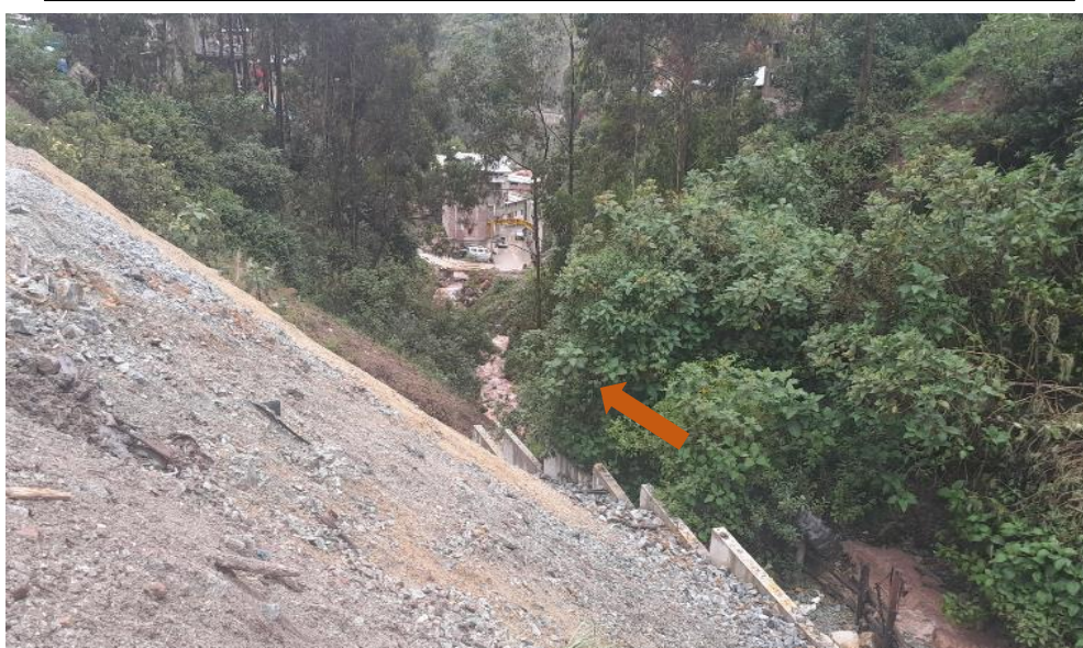
FIGURA N°03: EN EPOCAS DE INCREMENTO DE CAUDAL SE PROPONE UN ENROCADO DE 160 M EN LA MARGEN IZQUIERDA COMO MEDIDA DE PROTECCION
